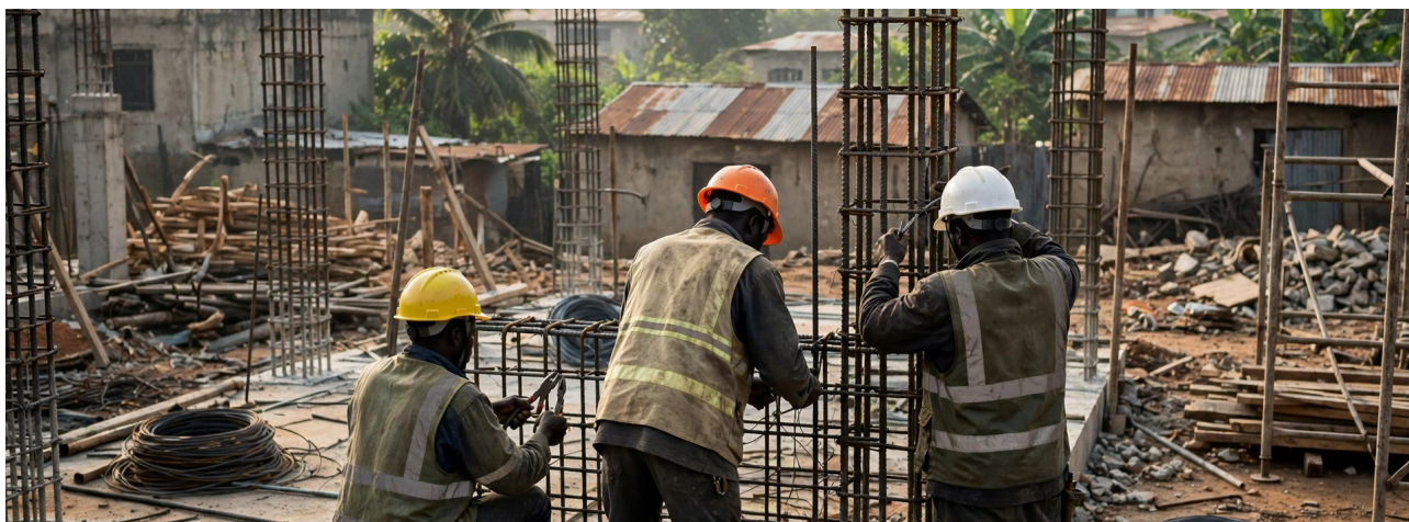
ILLUSTRATIF Vue d'illustration. Cages d'armatures sur un chantier : la construction est le principal effet d'entraînement en aval de l'acier long. Image générée ; ne représente aucun projet, lieu ou personne réels.
