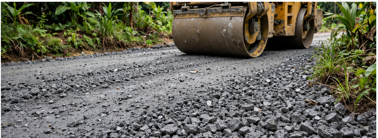
ILLUSTRATIF Vue d'illustration. Image générée d'une couche de fondation routière en granulats de laitier en cours de mise en œuvre ; il ne s'agit pas d'une photographie d'un projet, d'un lieu ou d'une personne.
